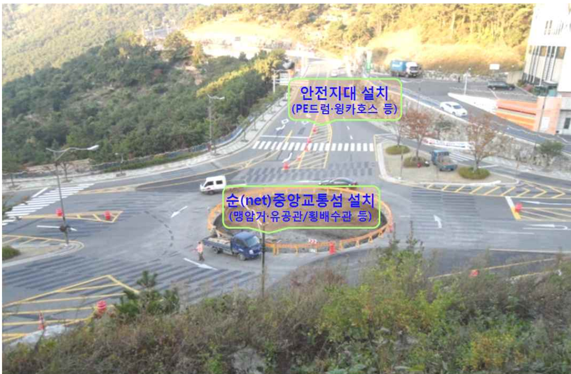
<그림 6-7-12> 중앙교통섬 및 분리교통섬 설치
