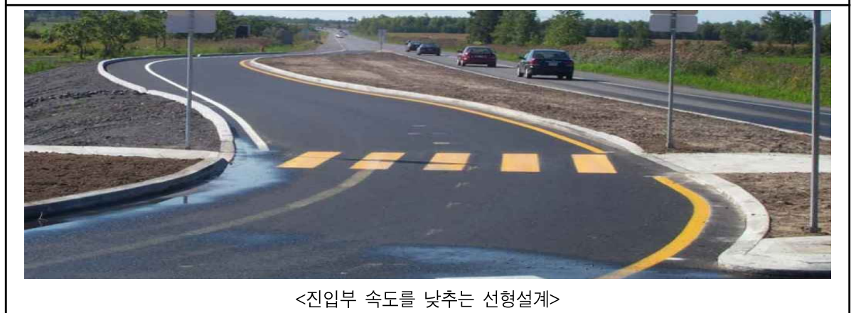
<그림 6-7-6> 4지 회전교차로 속도저감을 위한 진입부 설계
