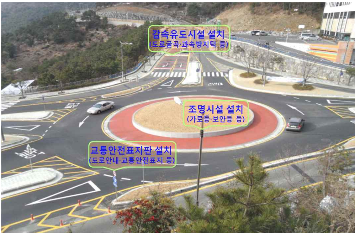
<그림 6-7-15> 도로 및 교통안전시설물, 부대시설 설치
